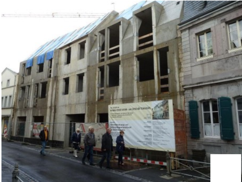
Gewerbefläche im Erdgeschoss, Wohnungen in den oberen Etagen: Im Frühjahr soll das Gebäude in der Altstadt bezugsfertig sein. Foto: Melzer
