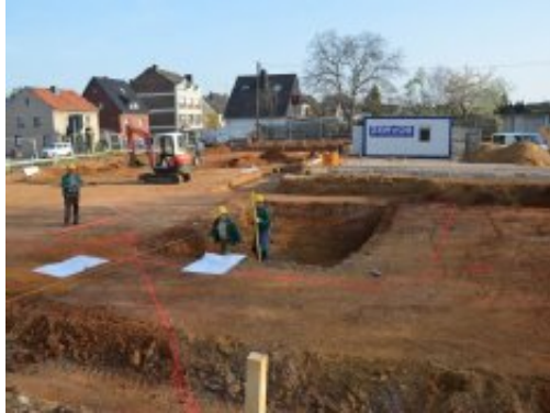
Massenberg-Grundstück Bauarbeiten haben die Bauarbeiten begonnen.
