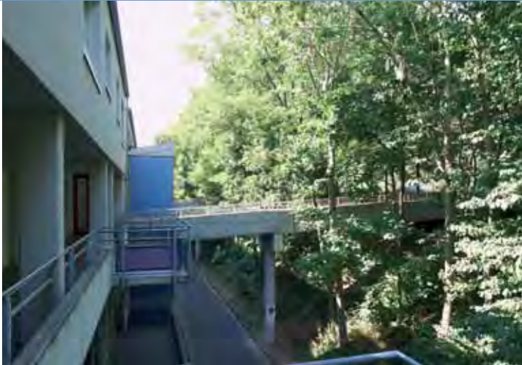
Niveaugleiche Brücken erschließen das erste Obergeschoss.
