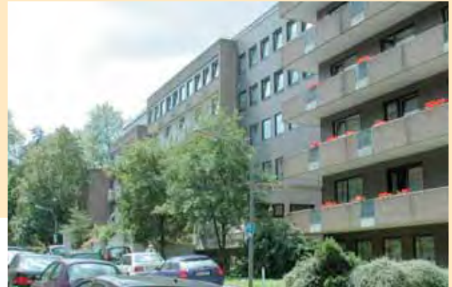
Straßenansicht vor der Modernisierung
